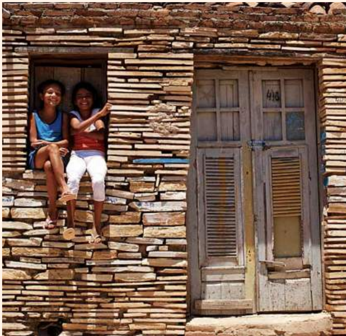
Casa revestida com Pedra Cariri.
