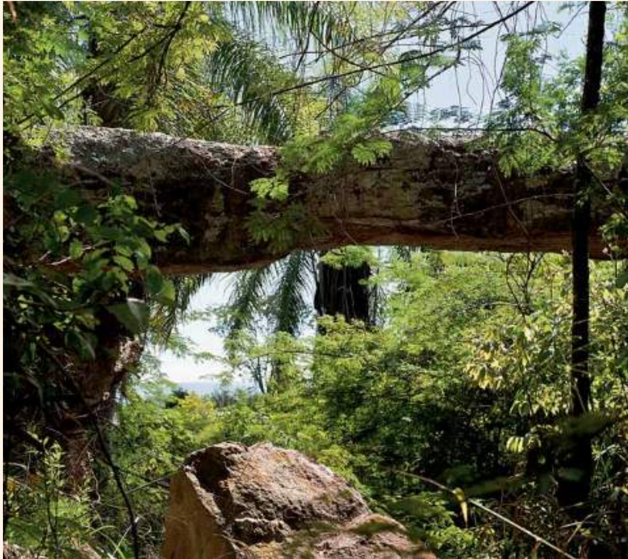
Arenitos da Formação Exu constituintes da ponte.
